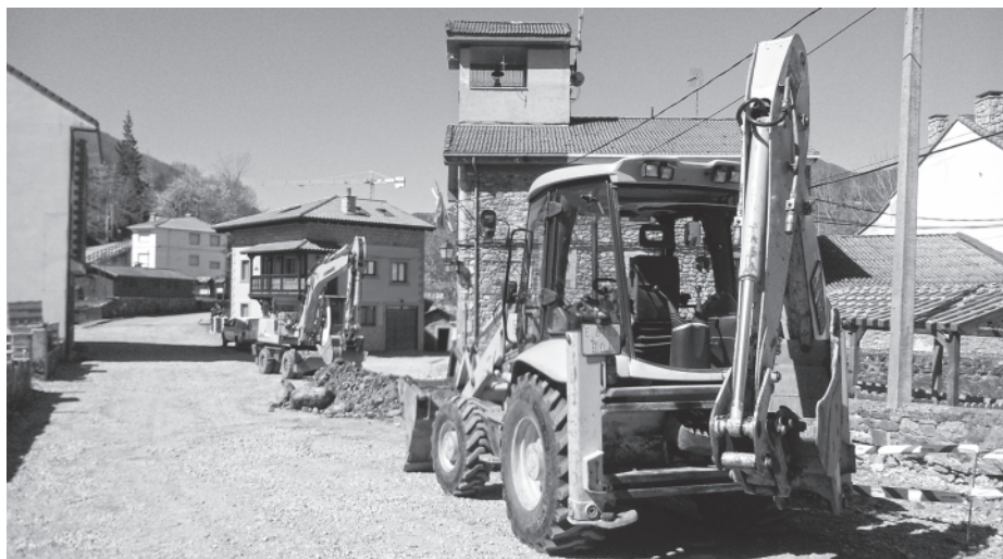
Obras de adoquinado en Posada.
